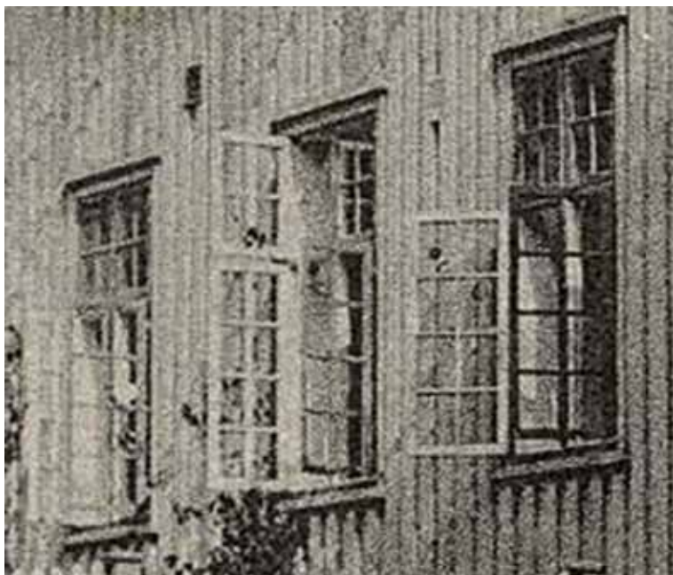
Utsnitt av fotografi fra før 1906. De åpne rammene viser tydelig avstand mellom ramme og karm som forutsetter bruk av stabelhengsler.
